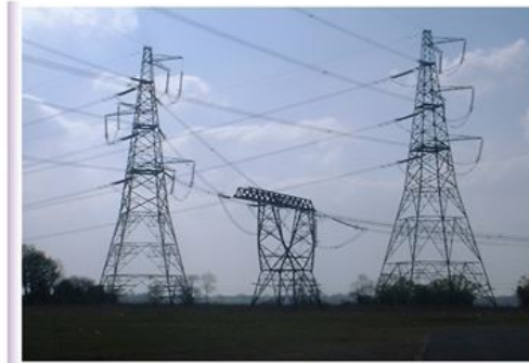
a) Viaduc b) aile d'avion c) pylône
